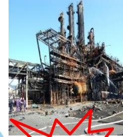
爆発火災・トラブル
