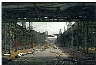
レゾルシン製造装置とサイメン製造装置間通路(レゾルシン製造装置:左側)
