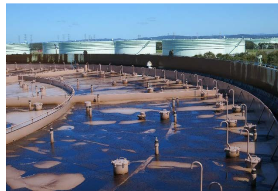
浮き屋根上に流出した原油
