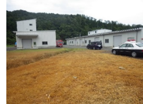
爆発飛散した化学物質により、敷地内の下草が枯れている
