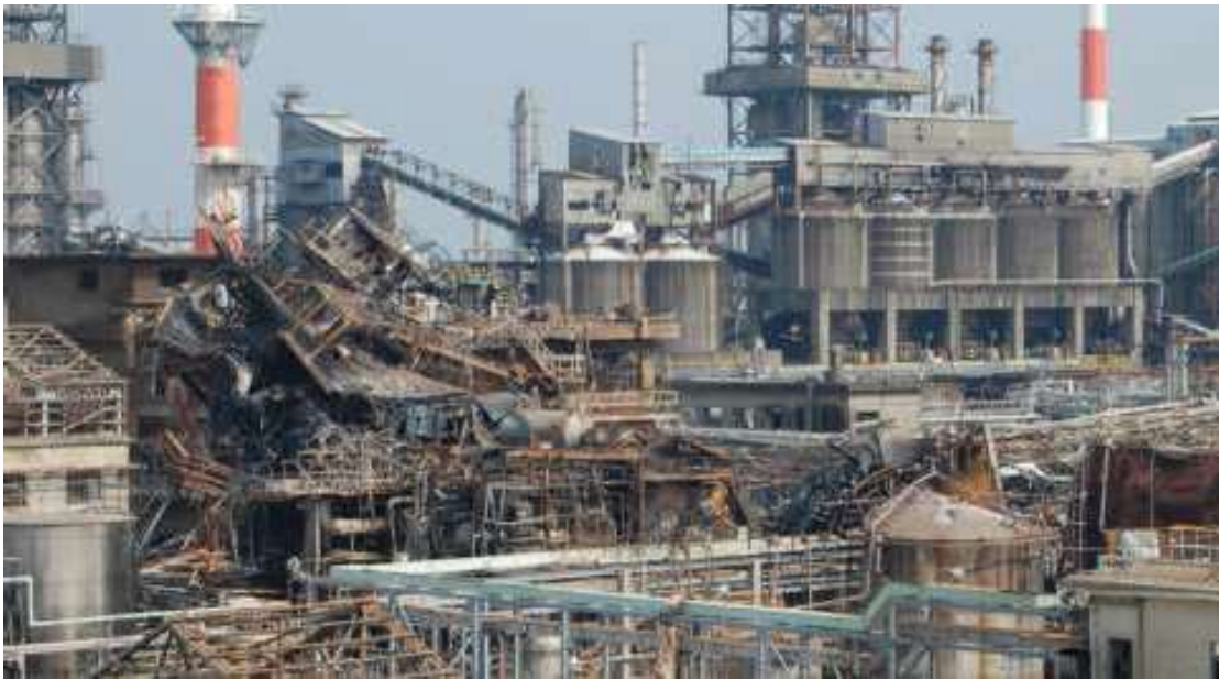
写真3-4-1 高圧ガス設備における爆発現場の例
