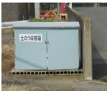
写真6-1-4 応急措置用の土のうの設置例
