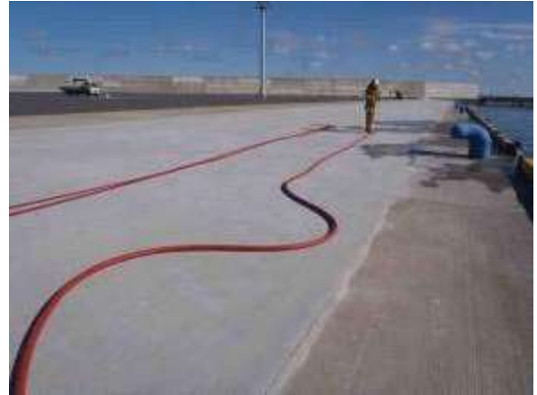
写真2-2-31 展張後の状況(横横巻き)
