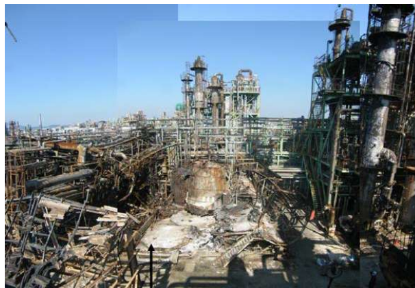
写真10-2-3 爆発したタンク
