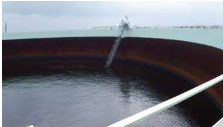
写真10-4-2 浮き屋根が完全に沈んだ状態
