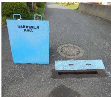
写真6-1-1 地下の排水溝を遮断する水門の例
