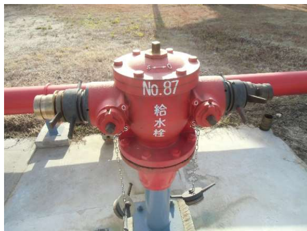
写真7-9-3 媒介金具を結合した状態（左側が75mm、右側が65mm）
