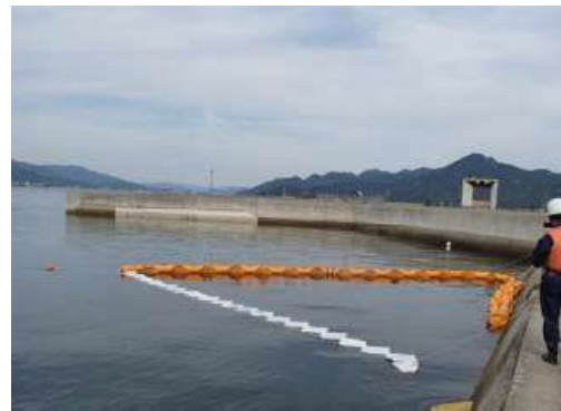
写真 8-8-8 吸着材フェンスと吹き流し状 吸着材による油膜の回収
