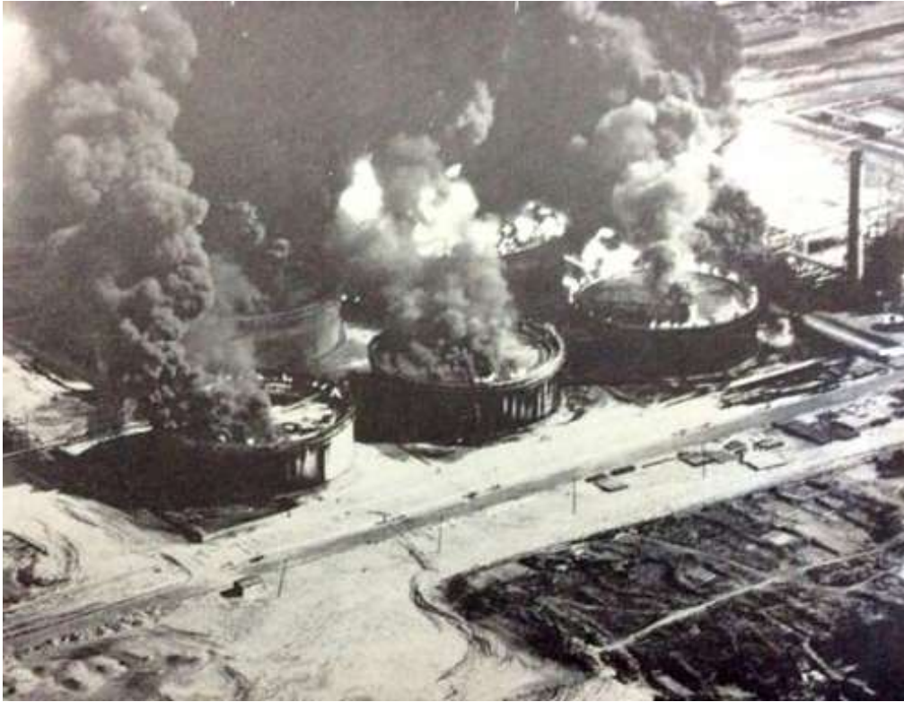
昭和39年 新潟地震 危険物タンク群の火災状況（防衛省提供）
