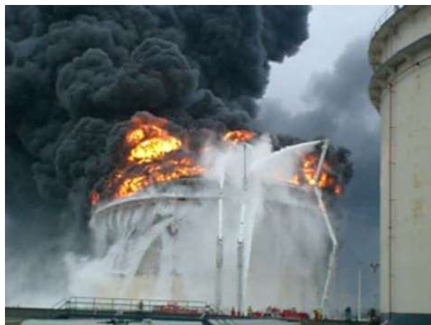
写真10-1-3 ナフサタンク火災
