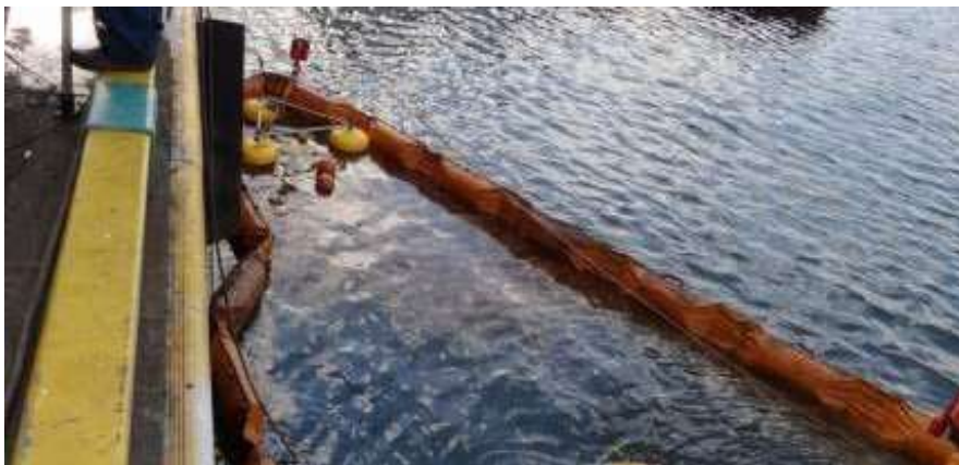
写真7-11-2 油回収装置による油回収
