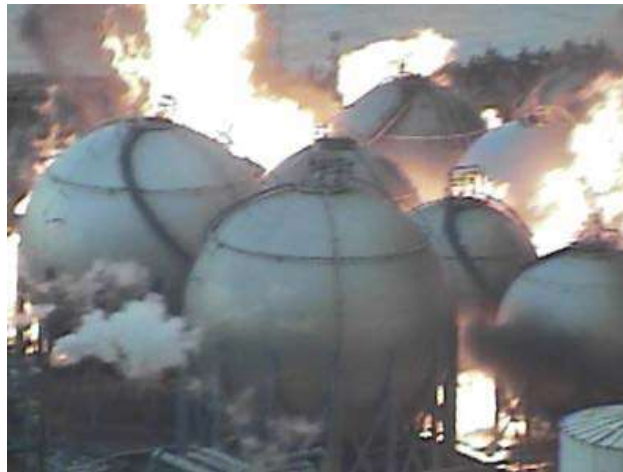
写真10-2-2 364番タンク 火災発生15時46分頃の状況
