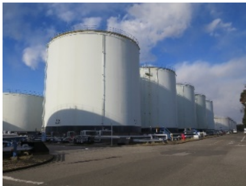
実証対象となるタンク
