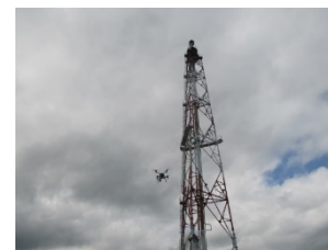
← フレアスタック (活用事例集より引用)
