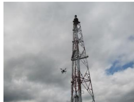
フレアスタック等の高所の検査 （ドローン活用事例集より引用）
