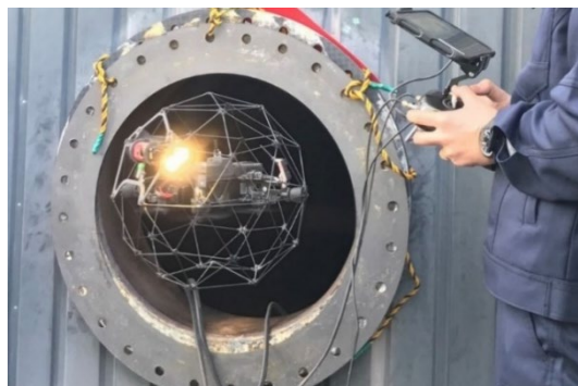
危険物タンクの点検孔に入る様子
