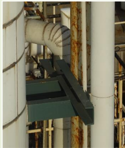
ドローン飛行で 得られた画像 目視では死角に なる接続部分
