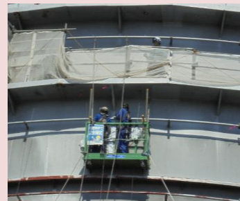
従来のゴンドラを 使った目視点検方法
