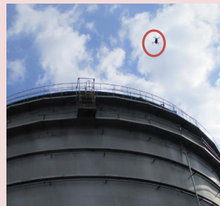
ドローン飛行状況
