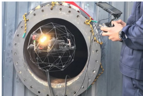
危険物タンクの点検孔に入る様子
