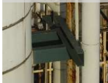
実証実験① ドローン飛行で得られた画像 目視では死角になる接続部分
