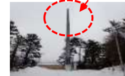
<風車の羽根の脱落>
