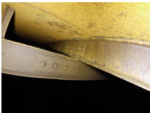
天井のボルト
