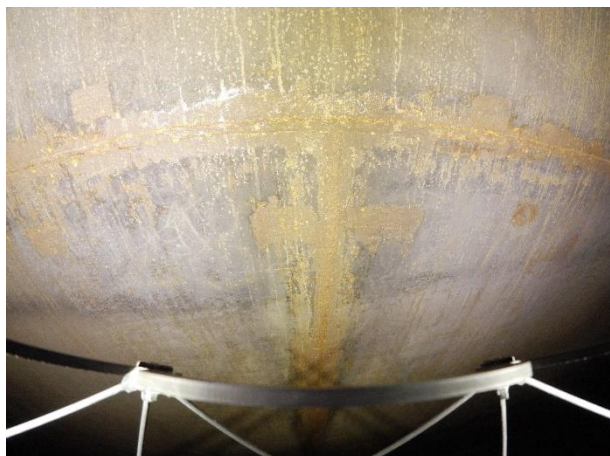
壁面の溶接線
