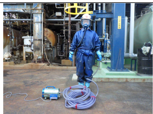
⑭エアラインマスクの接続状況
