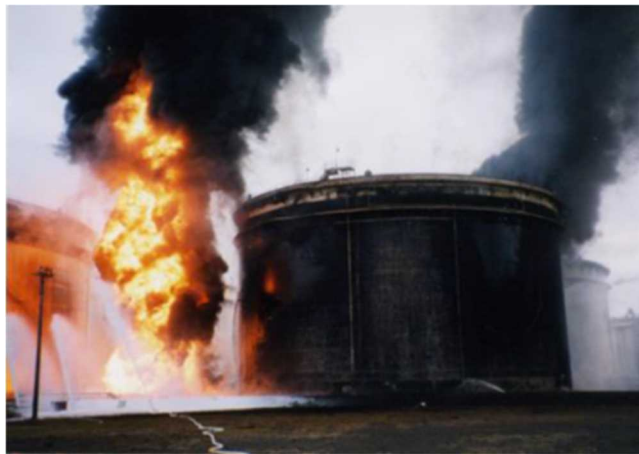
写真 10-1-2 原油タンク火災
