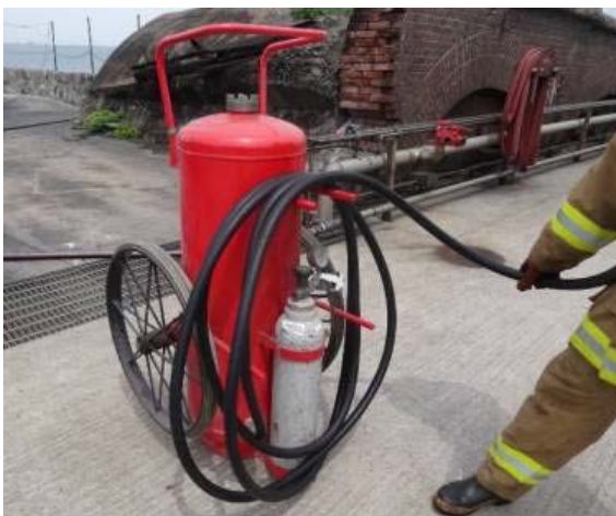
写真2-3-23 通常巻き(三巻き目)
