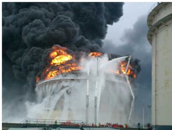
写真 10-1-3 ナフサタンク火災
