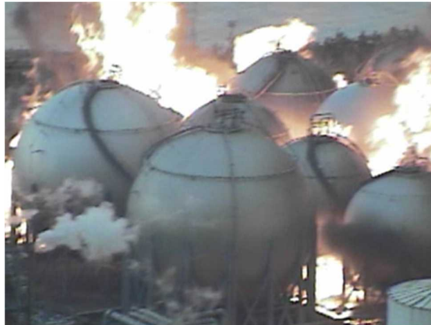
写真 10-2-2 364 番タンク 火災発生 15 時 46 分頃の状況
