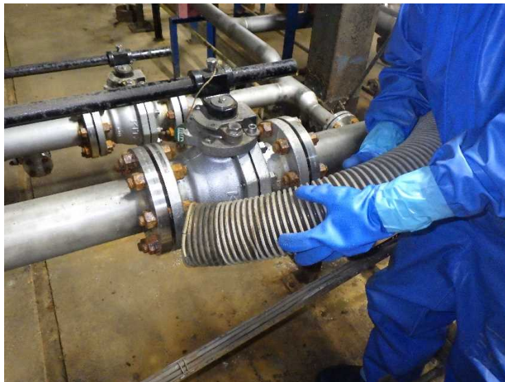
写真 8－3－10 ガス吸引設備によるガス拡散防止措置 (写真提供：セントラル硝子株式会社川崎工場)
