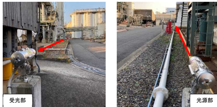
オープンパス式赤外線ガス検知器
