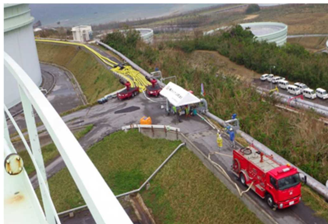
写真 10-4-3 大容量泡放射システムの配置状況
