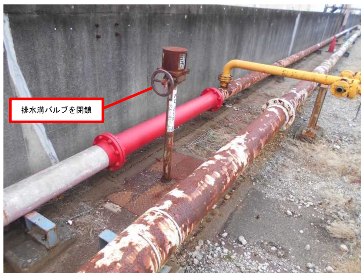
写真 8－3－1 2 排水溝閉鎖による拡散防止措置
