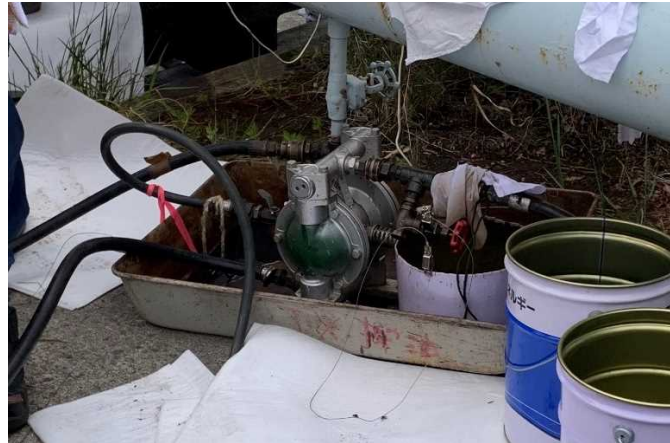
写真 8－3－8 ポンプによる危険物の回収
