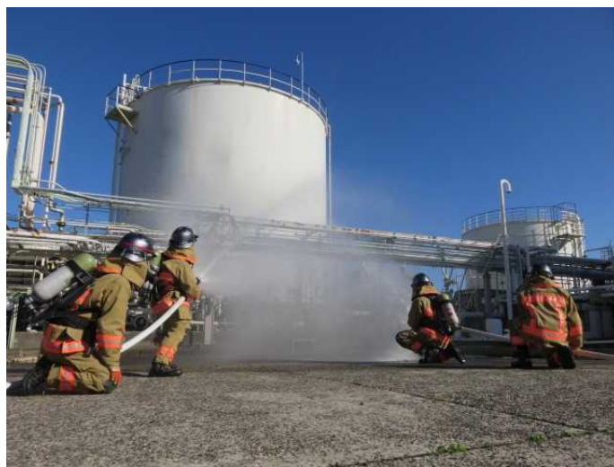
写真 8－3－1 3 水噴霧注水によるガス拡散防止措置 (写真提供：株式会社ENEOSマテリアル四日市工場)
