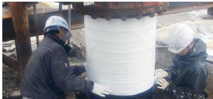
写真 8－3－9 応急用固定バンドの例（マホータイの施工）
