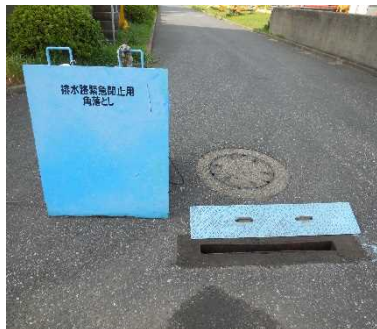
写真 6－1－1 地下の排水溝を遮断する水門の例
