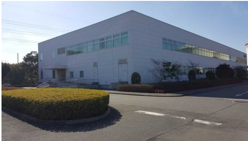
写真5－1－5 事務管理施設地区（富士石油株式会社提供）
