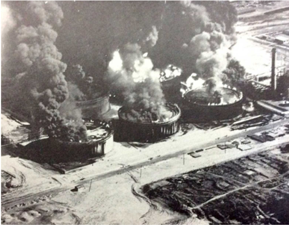
昭和 39 年 新潟地震 危険物タンク群の火災状況（防衛省提供）
