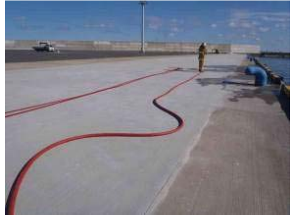
写真2-2-31 展張後の状況(横横巻き)
