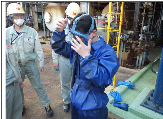
⑥面体又はマスクを着装します。 危険性や活動時間に応じて、防毒マスク（⑦参照）、空気呼吸器、エアラインマスク（⑧参照）などマスクの種類を選択します。
