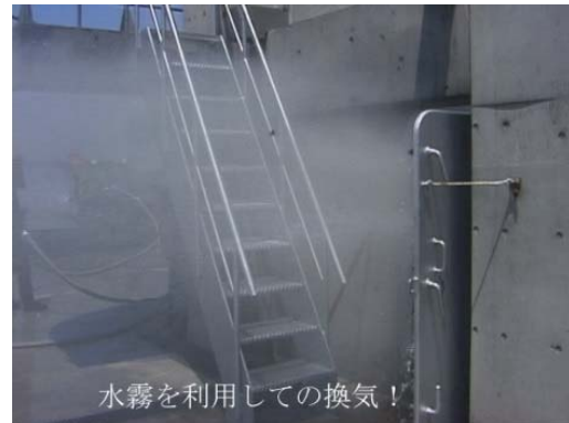
写真3-1-5 水霧による換気の状態
