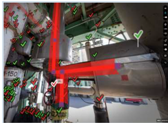
図: フランジ、配管ラインの検出とタッチアップ
