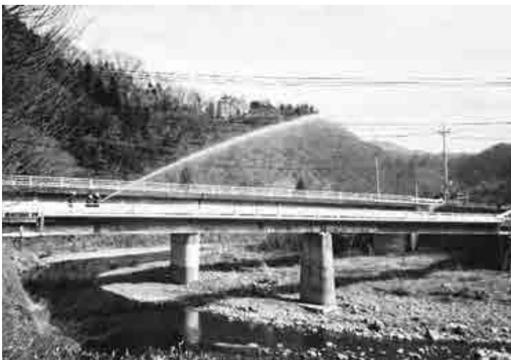
約400mのホース延長を行い放水
