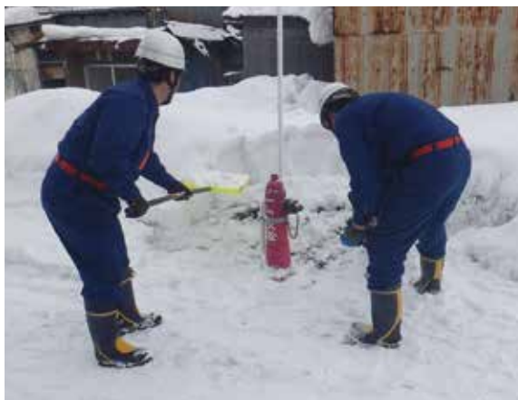
積雪時には消防水利確保のため、消火栓の除雪作業を実施
