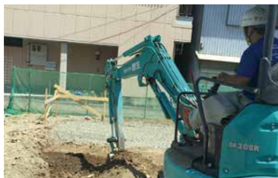
重機取扱い資格のある従業員(団員)による重機の取扱いの様子
