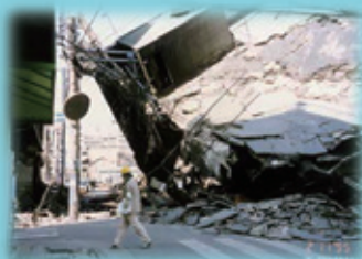
道路までくずれた建物
