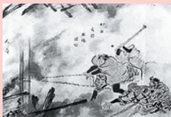
江戸時代の破壊消防 (大阪市消防局提供)
