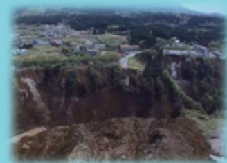
くずれ落ちた橋
