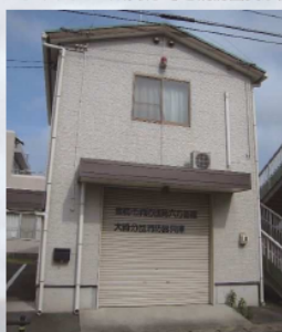
▲実施前のシャッターの様子
