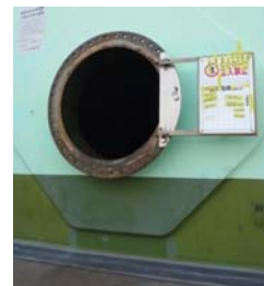
No.3マンホール （入槽口）
