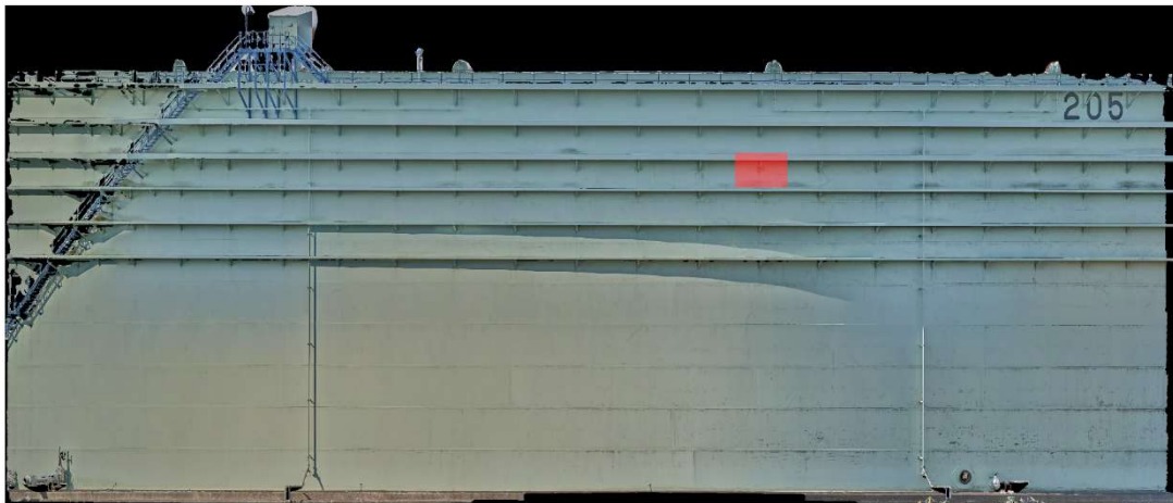
図 22 損傷位置記録方法の一案 全体像（イメージ）
