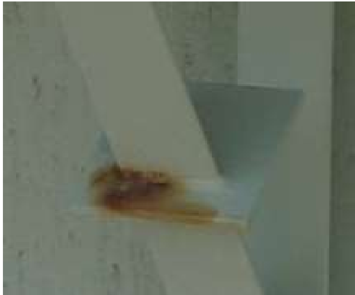
図 43 4K 動画(8MP,撮影距離 10m, 2.7mm/px)
