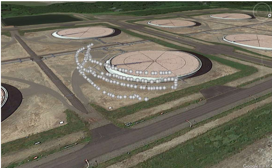
図 19 自律飛行によってタンクの側面を自動撮影した際の撮影ポイント（斜め横から）
