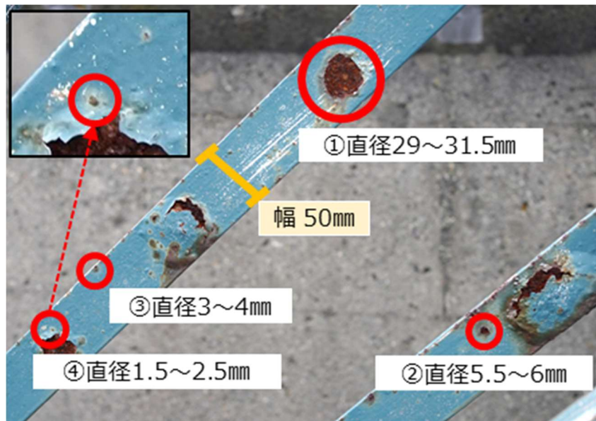
図 32 検証に用いた実腐食と各腐食の寸法（撮影距離 1m、6,100 万画素）
