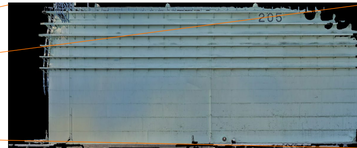
オルソ画像（離隔約24m※1の距離から撮影した114枚の静止画から北東・東・南東の三枚を生成）※2
