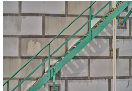
目印となる配管を含めて撮影することで、階段のどの位置の静止画であるかを確認できた
