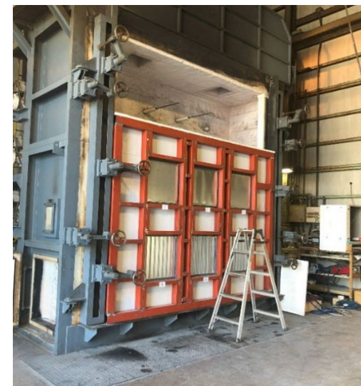
＜加熱炉の全景＞
