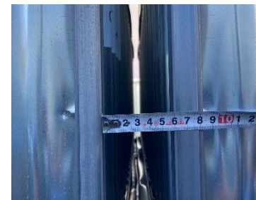
容器同士の間隔-前後約6cm (場所によって変動)
