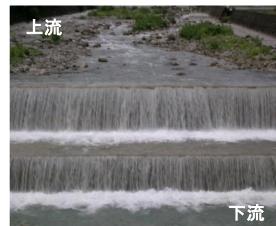
写真 3-12 ローヘッドダム
