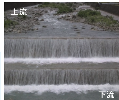
写真 4-11 ローヘッドダム
