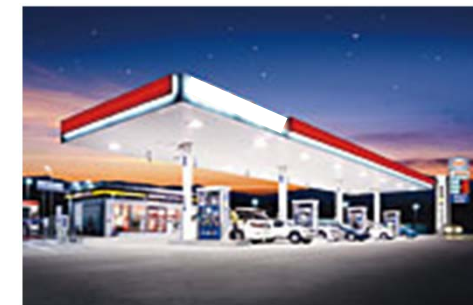
給油取扱所(ガソリンスタンド)の例
