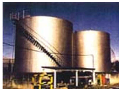
屋外タンク貯蔵所の例
