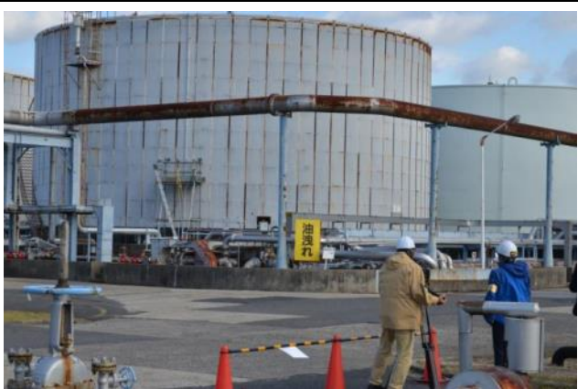
灯油タンクから防油堤内への漏洩発生
