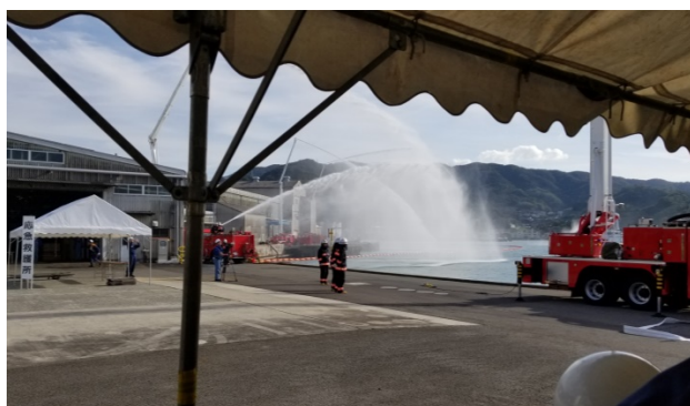
一斉放水（陸上）
