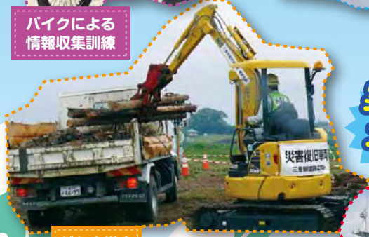
がれき撤去 訓練
