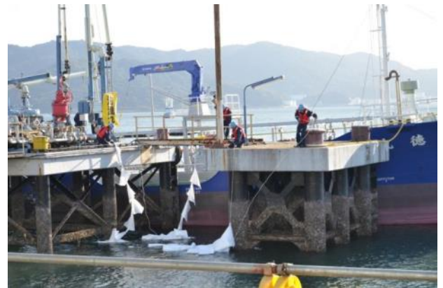
吸着マットによる浮流油回収
