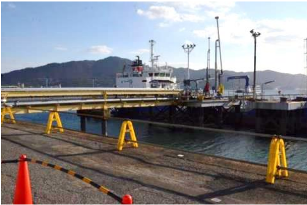
ローディングアーム破損による重油の海上漏洩
