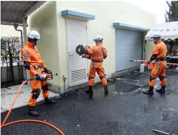
【座屈耐火建物救助訓練】
