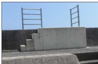
コンクリート閉鎖及び階段の設置
