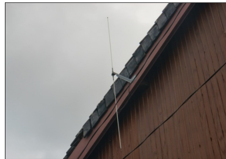
<外部アンテナの設置状況>
