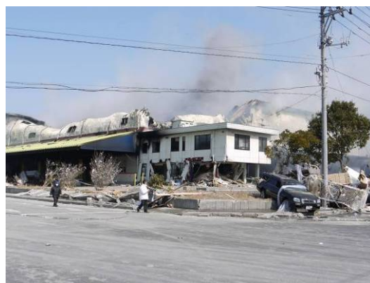
東邦運輸倉庫外観
