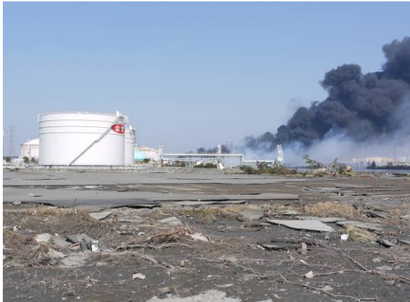
黒煙噴出・炎上確認 (出火箇所南側)
