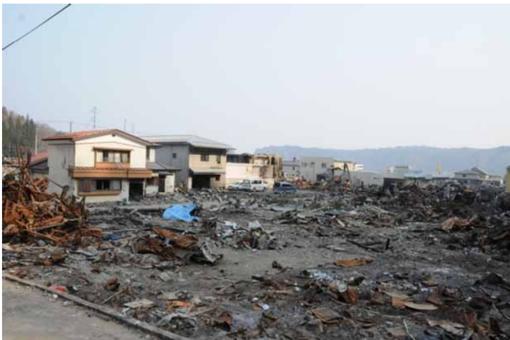
写真1 ケラス地区の焼損状況 奥が海。2011年4月14日撮影。
