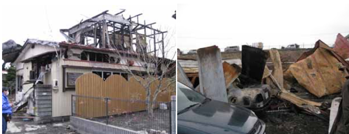
写真 10 蛇田地区で焼損した住宅と車両の状況
