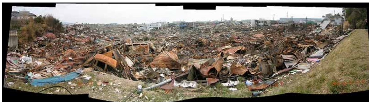
写真 9 門脇小学校付近の焼損状況 高台の崖の上から南東を見た状況。奥が海。 2011 年 3 月 31 日撮影。
