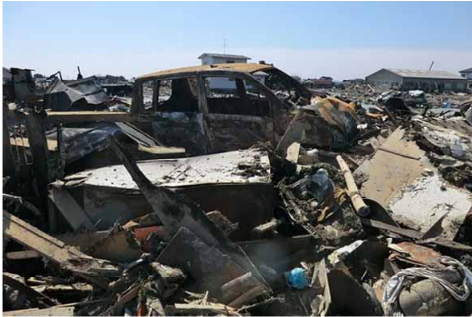
写真 12 川岸に確認できる焼損したガレキや自動車の状況 2011 年 4 月 1 日撮影
