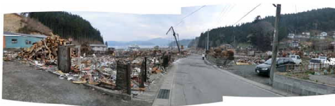
写真 5 赤浜地区の焼損状況 奥が海。左手前側の焼失した家屋 3 棟は津波被害なし。 2011 年 4 月 27 日撮影。
