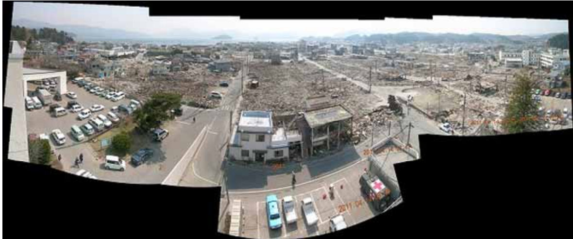
写真 2 山田町役場屋上から見た焼損状況 奥が海。2011 年 4 月 13 日撮影。
