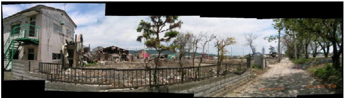
写真 7 内の脇地区の延焼範囲を北西側から見た状況。 右側土手のさらに右は大川。2011 年 7 月 6 日撮影。
