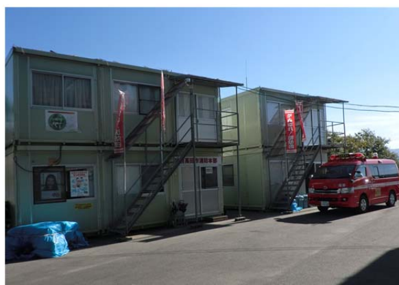
【被災後に拠点を移動した陸前高田市消防本部の仮設庁舎】 （陸前高田市消防本部提供）
