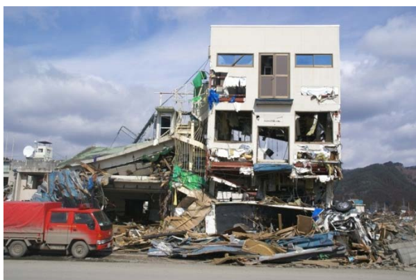
【津波被害を受けた消防署の状況】 （釜石大槌地区行政事務組合消防本部提供）
