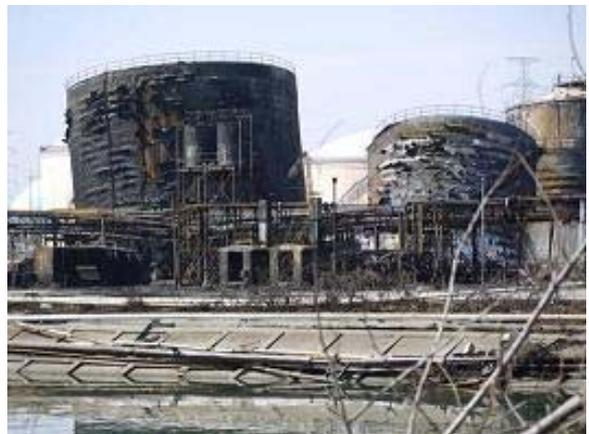
焼損した屋外貯蔵タンクの外観
