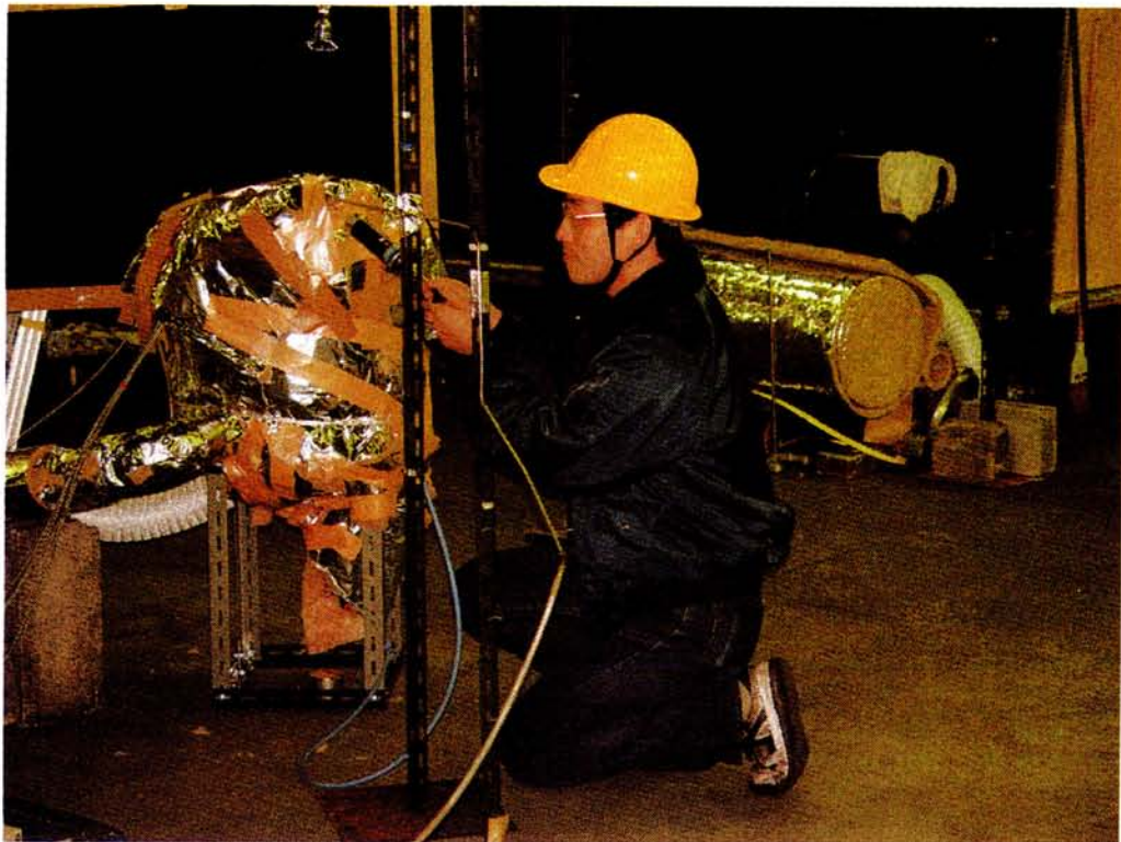
図5 検知管を用いたガス濃度測定
