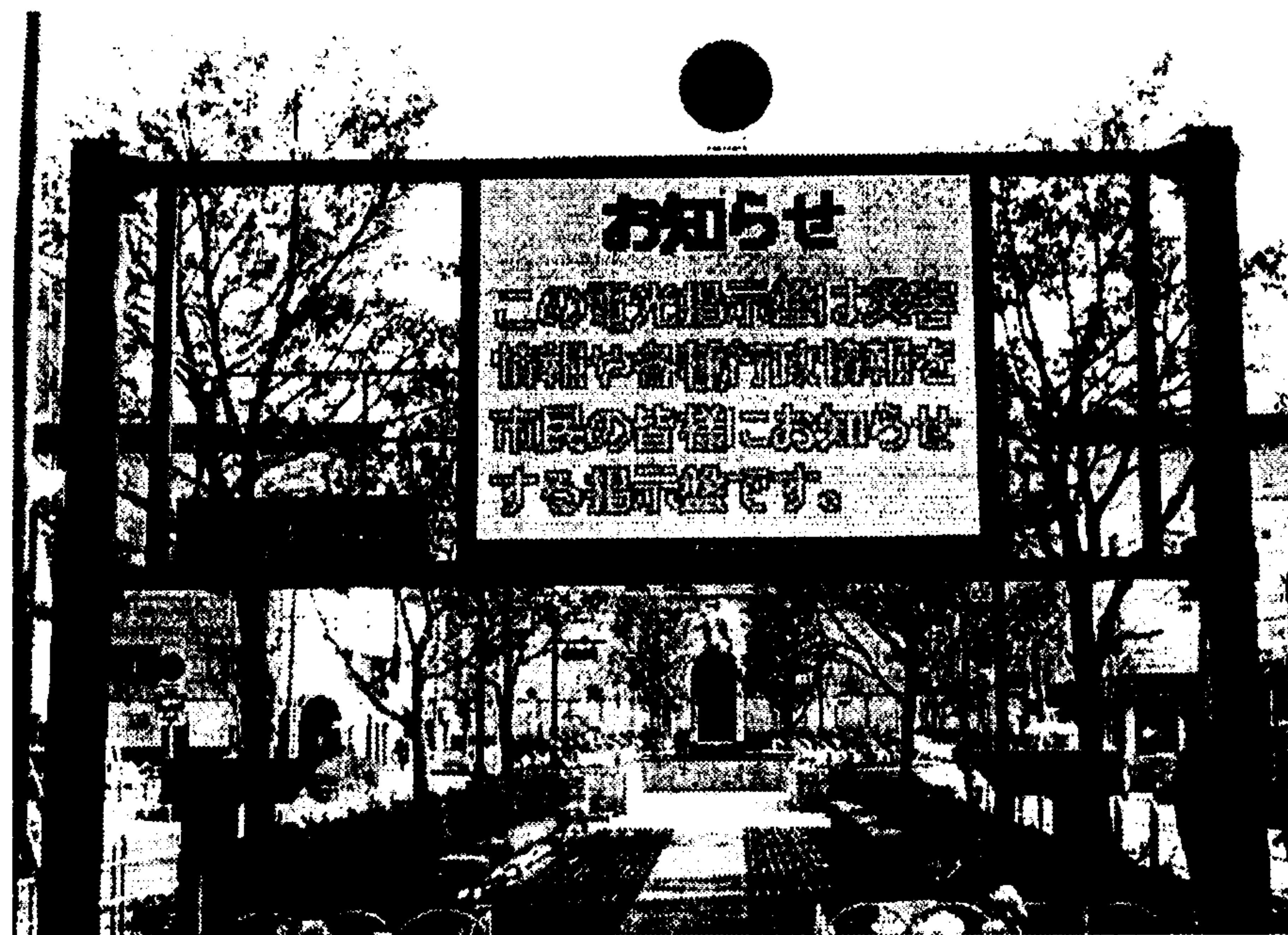
釜石湾防災情報表示システム
