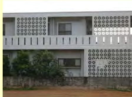
台風時の飛来物に備え、花ブロックなどで囲んでいる。
