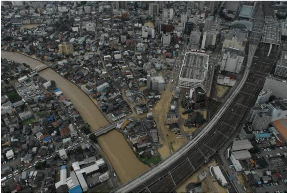
堀川町地内（金沢市提供）
