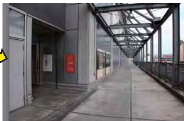
《屋外避難デッキ》
