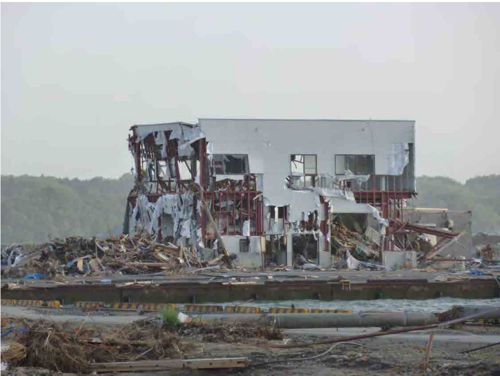
被災地における津波被害の状況（平成23年5月12日撮影）
