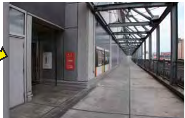
《屋外避難デッキ》
