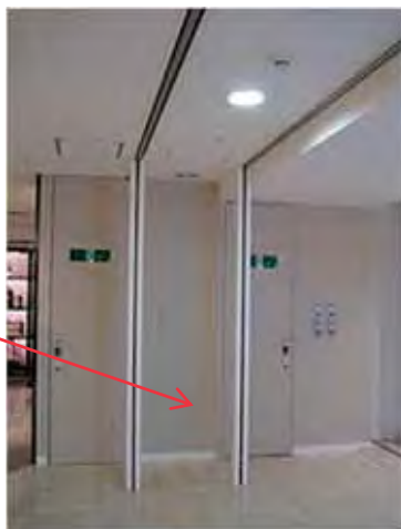
《店舗エリア開口部における二重の防火シャッターの例》
