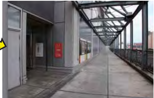
《屋外避難デッキ》
