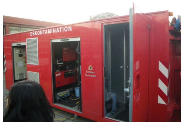
【隊員用除染コンテナ】
