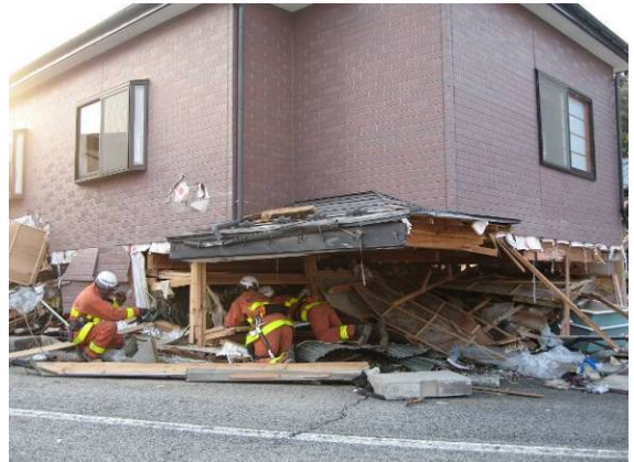
3月13日 岩手県山田町での座屈建物の検索（秋田県隊）
