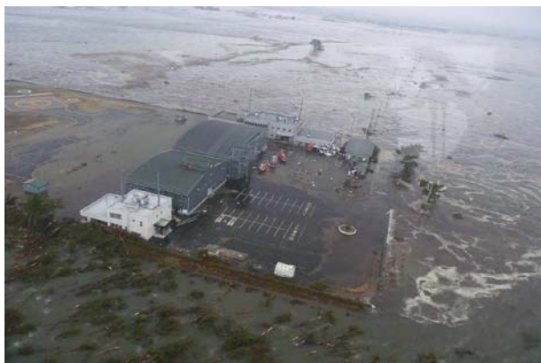
津波直後の仙台市消防局荒浜航空分署
