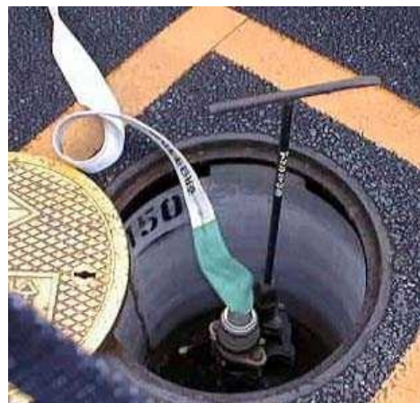
図 8-9 消火栓でスピンドルドライバー使用中の例
