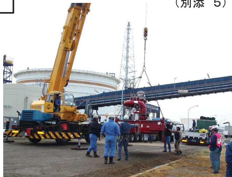
②-1 大容量泡放射システムの設置
