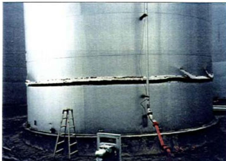
写真 4.3 危険物タンク(容量 990kl)の象の脚座屈(神戸東地区)<sup>7)</sup>
