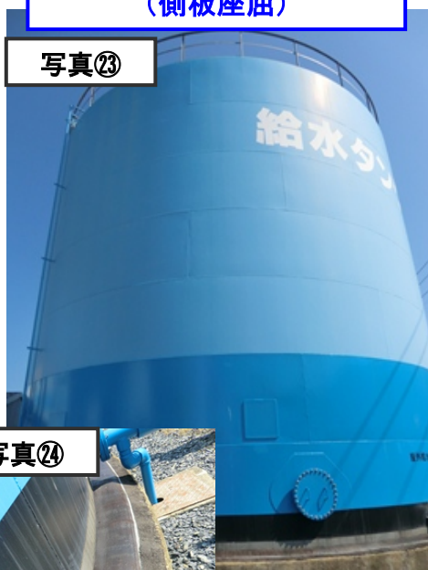
鋼製貯水槽 （側板座屈）
