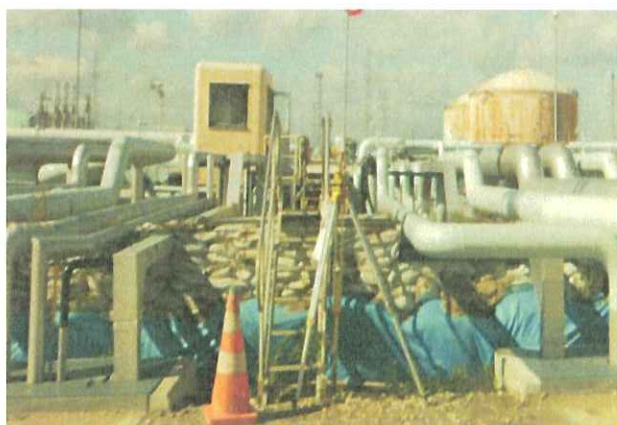
（土嚢積みの例）
