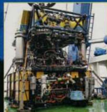
海底で設置作業を行うROV
