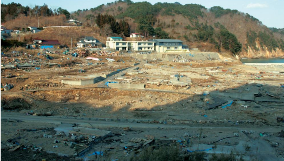
津波は漁港を襲い千鶏小学校の高さにまで達した
